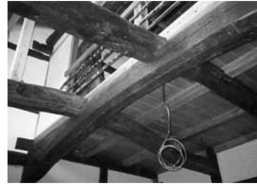
一階 板の間の天井
