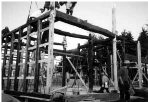
上 大黒柱に梁の掛かった所 下 西側玄関より土間部分
