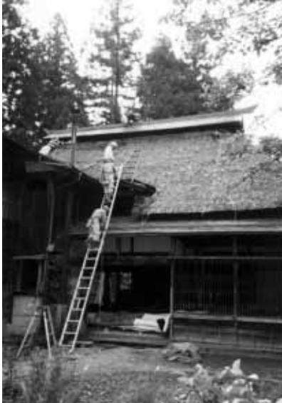
正面式台上部。5月29日着工
